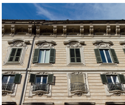
Renowacje i modernizacje budynków (w tym zabytkowych)
