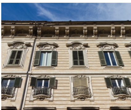
Renowacje i modernizacje budynków (w tym zabytkowych)
