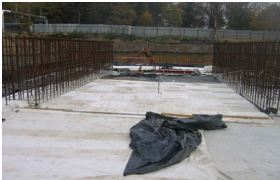
Zdjęcie 4. Zabezpieczenie płyty fundamentowej geowłókniną, styropianem i osłoną z folii
