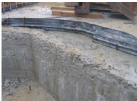
Zdjęcie 1. Uszkodzenie ściany fundamentowej wskutek przemrożenia świeżego betonu
