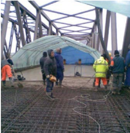
Zdjęcie 5. Wykonanie robót z zastosowaniem ciepłaka
