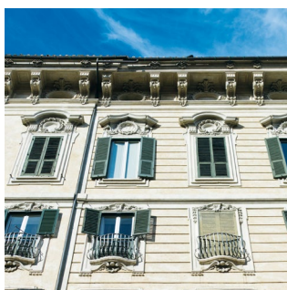
Renowacje i modernizacje budynków (w tym zabytkowych)
