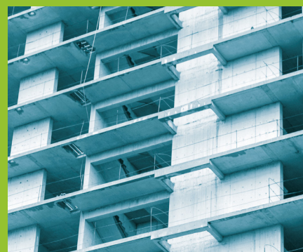
Podłogi na stropach międzykondygnacyjnych
