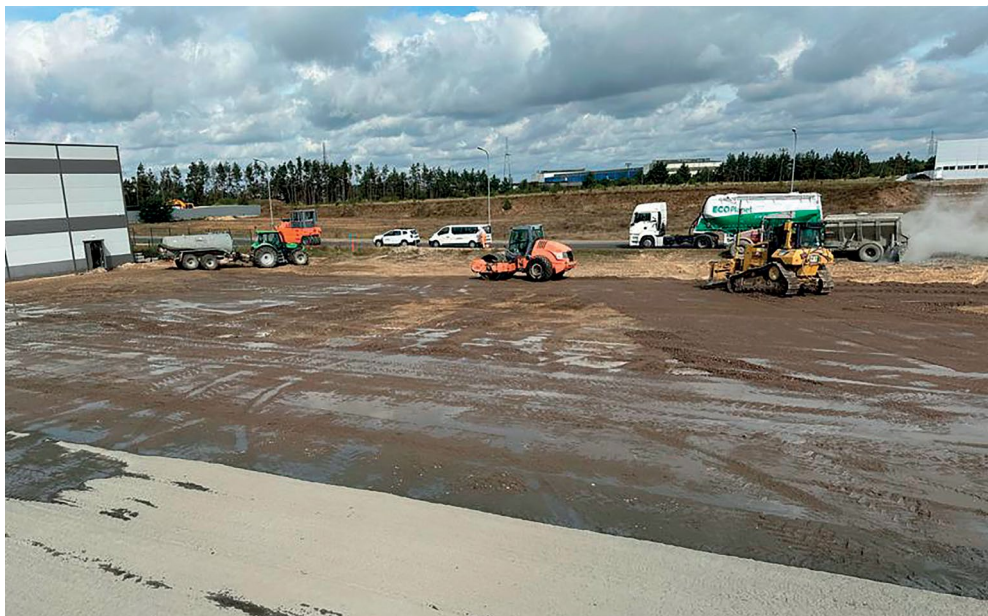
Dozowanie spoiwa w warunkach budowy
