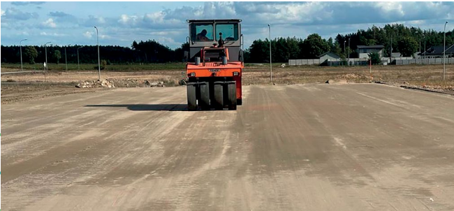
Zagęszczanie stabilizacji – walec stalowy i gumowy
