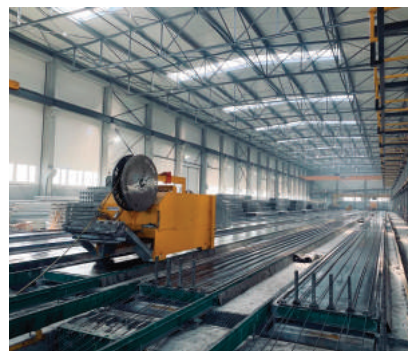
Fot. 8. Tory produkcyjne sprężonych płyt kanałowych
