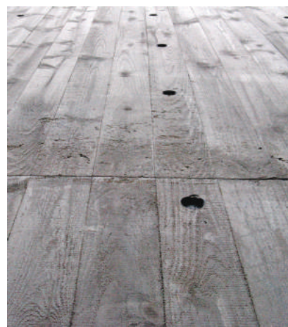
Fot. 5. Perfekcyjne odwzorowanie w betonie drewnianej deski
