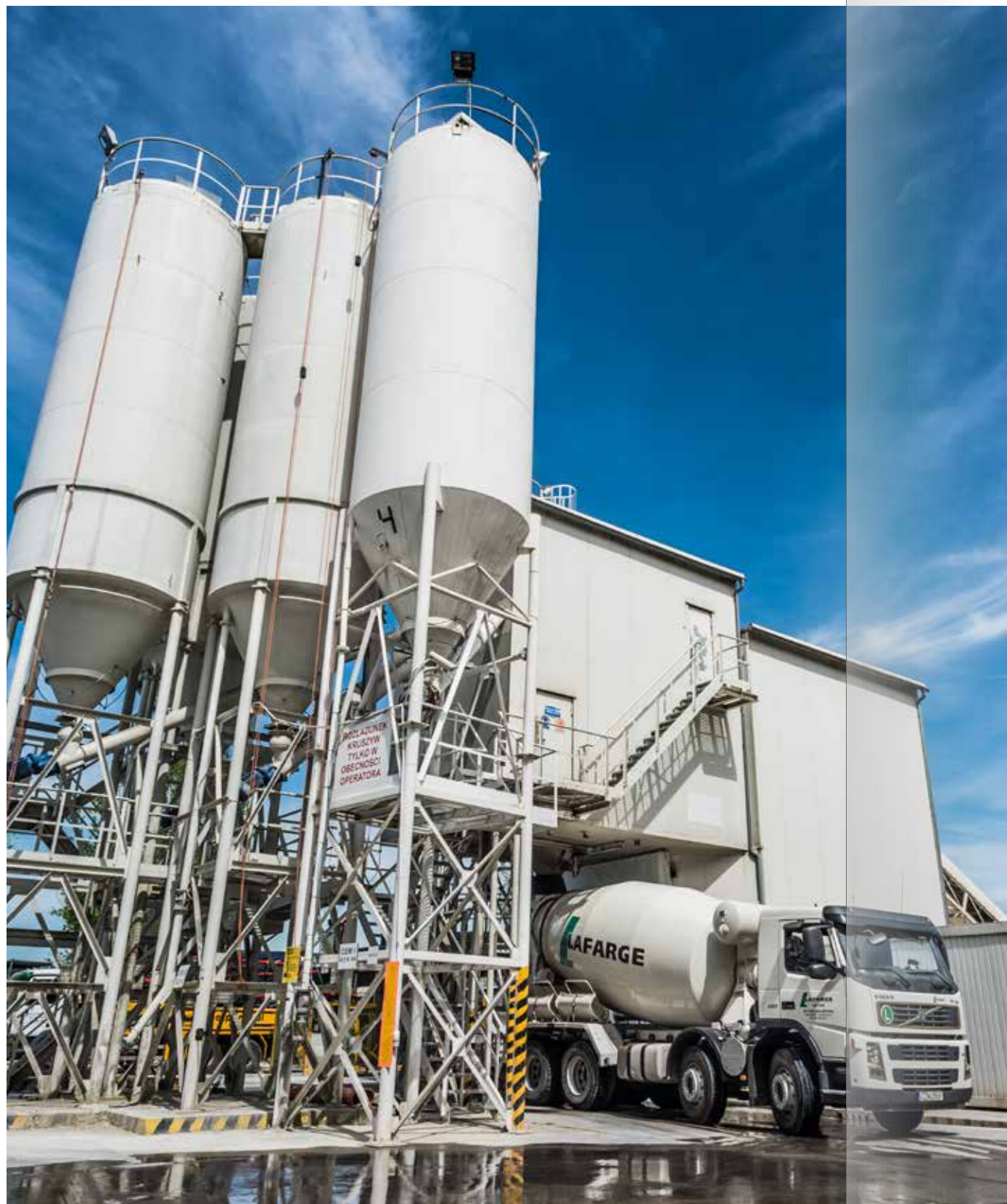
Wytwórnia Betonu Towarowego w Bydgoszczy
